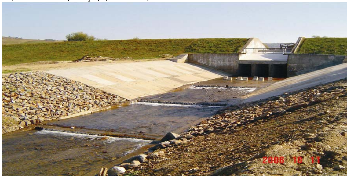
Fig. 1. Barajul acumulării Ciutelec
