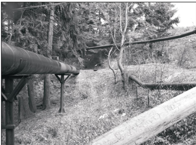
Foto 3 Conducte de transport a apei de la captarea Caraiman II
