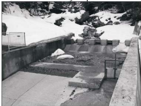
Foto 1 Aspect al captării de apă de pe Valea Albă – punct captare
