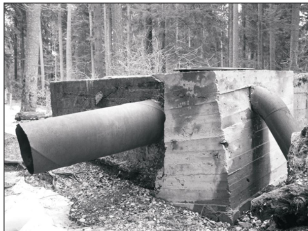
Foto 4 Conducte de transport a apei de la captarea Urlătoarea Mare-casa de presiune
