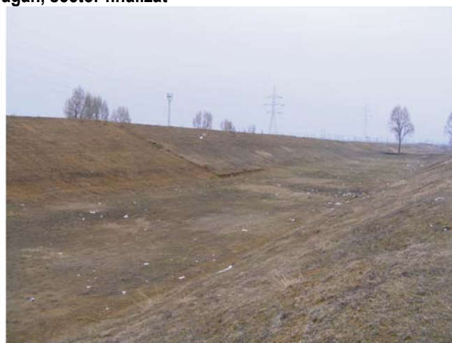
Foto 4 Canalul Siret-Bărăgan trasare
