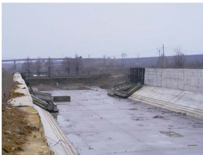
Foto 2 Canalul Siret-Bărăgan, priza Mărășești
