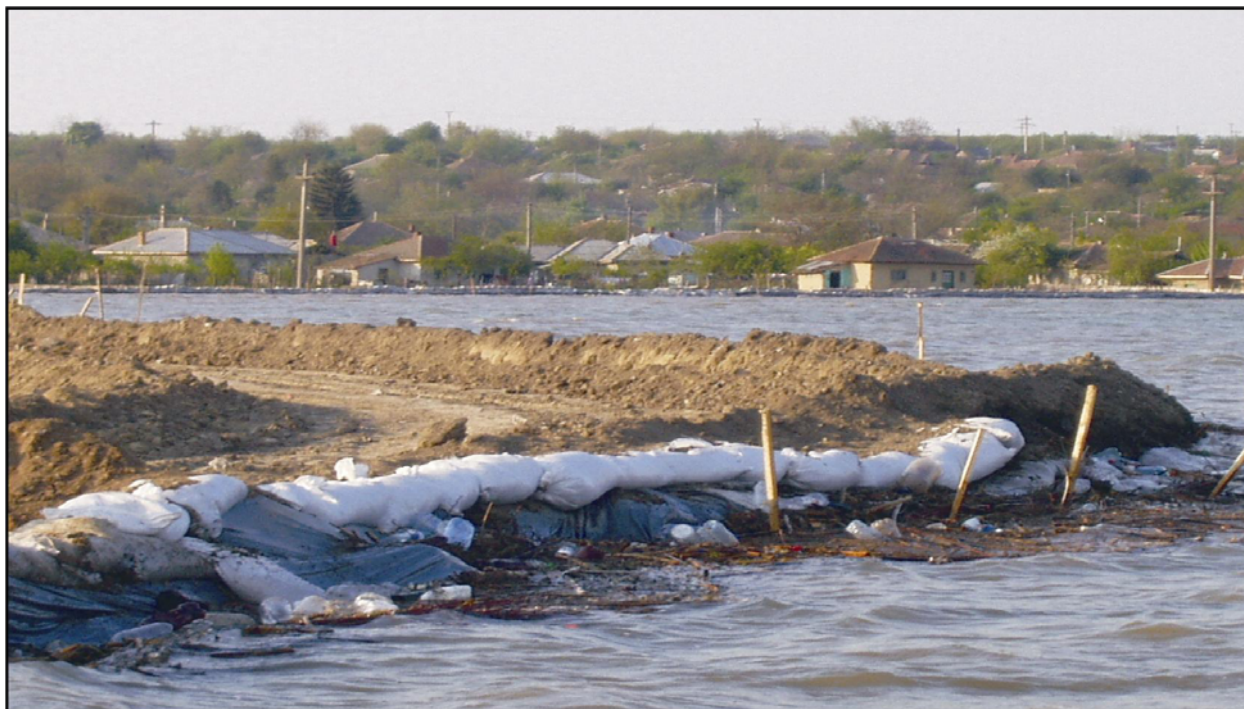
Fig. 21 Al doilea dig de apărare în dreptul localității Fetești ( Foto: M. Spahiu )
