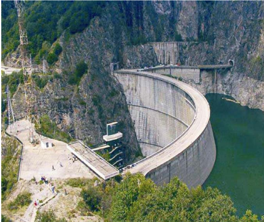
Fig. 4. Vidraru Lake dam
